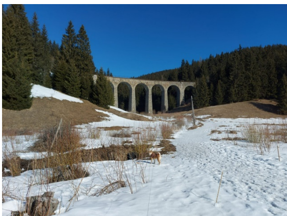
Obr. 1 Pohľad na viadukt
